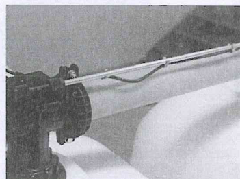
Etape 7- Fixer le câble de connexion (22) au tuyau de soutirage en Alu-Ø10mm (15) à l'aide des agrafes en plastique (23).
